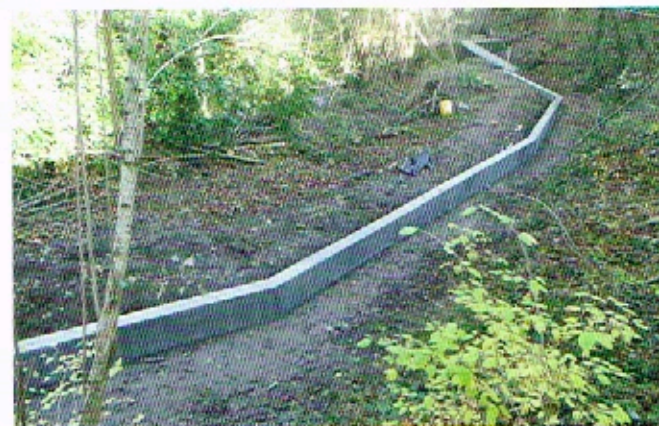
Le bief restauré avant sa remise en eau
