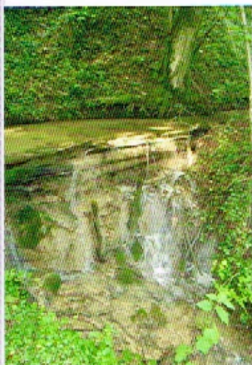
Fuite sur le bief avant travaux
