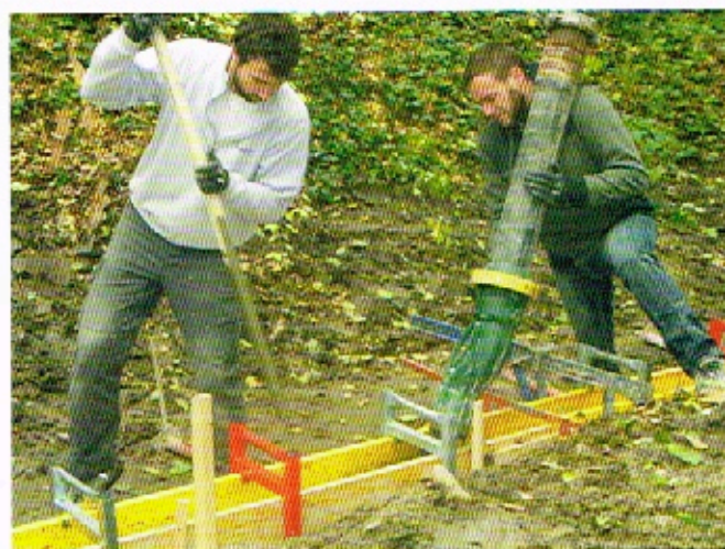
L'entreprise DUBOULOZ au boulot (remplissage des coffrages)
