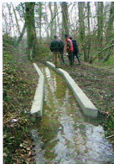
Fuite réparée par la mise en place d'un caniveau béton
